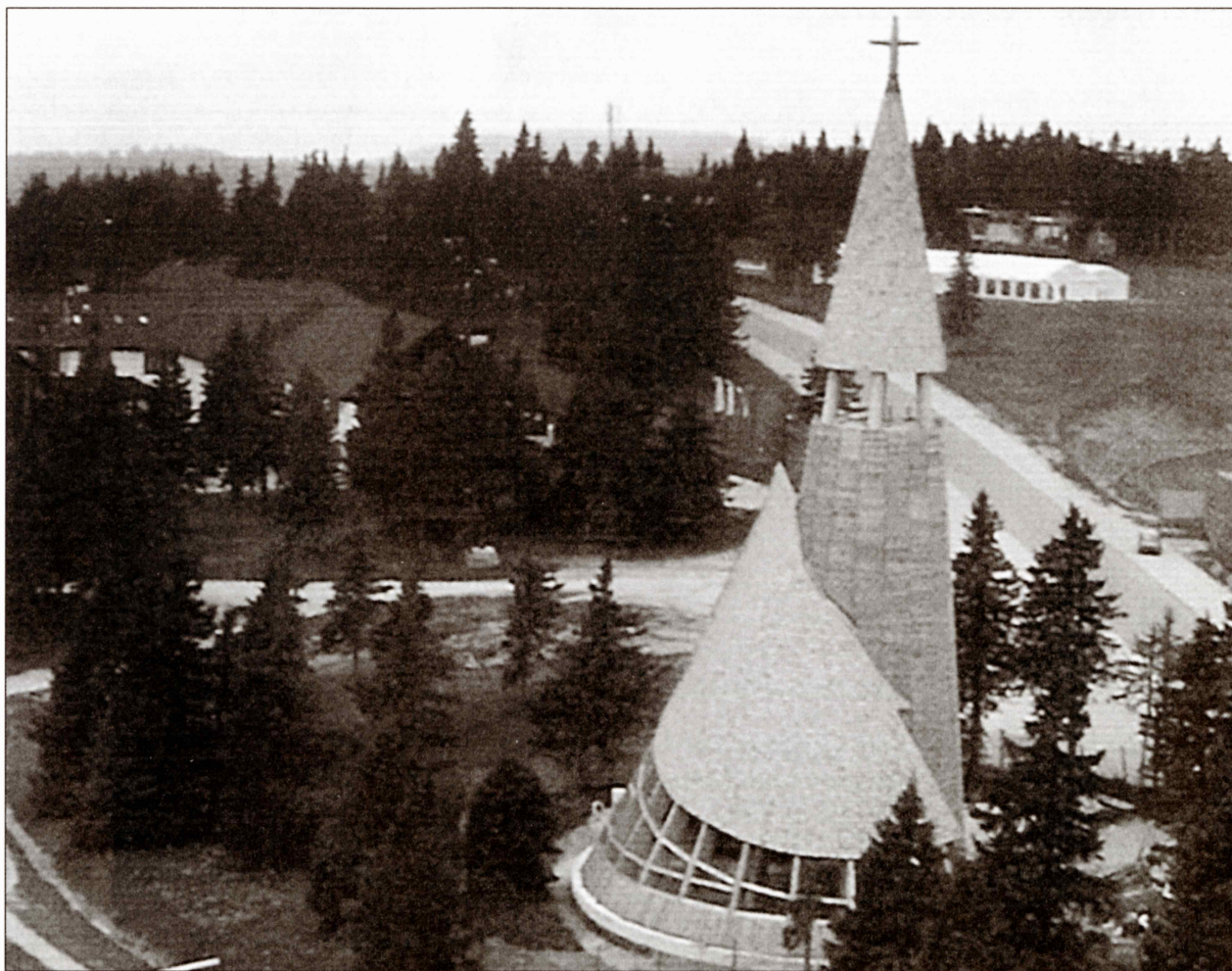
Cerkev Gospodovega spremenjenja na gori med gradnjo
