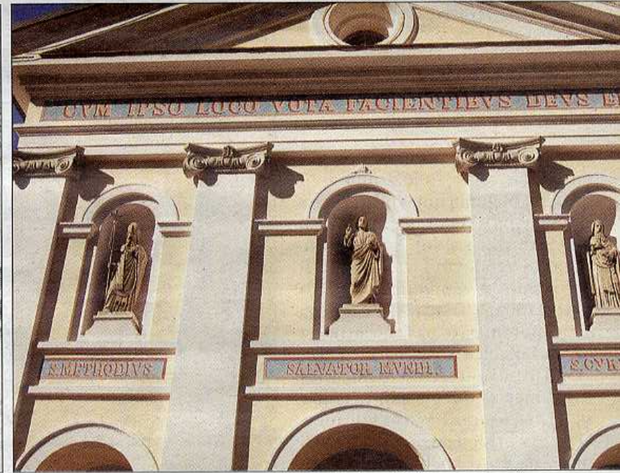
Po obnovitvi pred leti si ne bi nihče mislil, da je ta cerkev leta 1944 doživela hudo uničenje (foto: I. Ž.)
