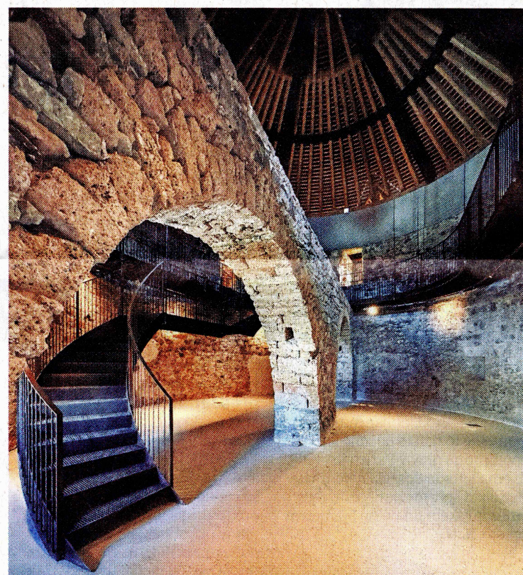
V nasprotju s palacijem je bastija precej bolj robustna in mogočna. V njej so izdelali zahtevno jekleno konstrukcijo, ki je v celoti obešena na streho.
