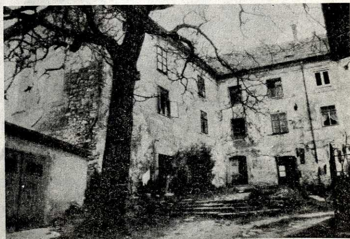
Zgrada obitelji Pažur u Krapini u kojoj se svibnja 1945. nalazila uprava civilne OZNE.
