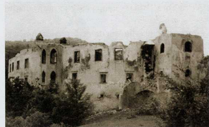
Ruševine Klevčevža po požigu
