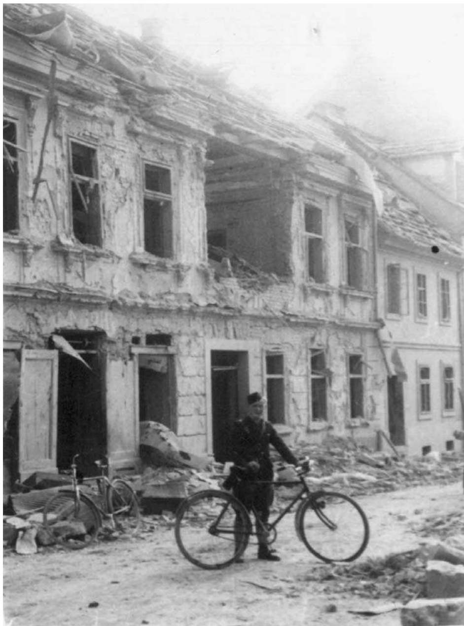
4. oktober 1943. Težko poškodovani hiši ob glavni ulici, najverjetneje stavbi Adolfa Malneriča (št. 11) in Vinka Leitgeba (št. 13). Pred stavbo neznani kolesar. (Foto: Ivan Pirnat, original hrani Belokranjski muzej Metlika)
