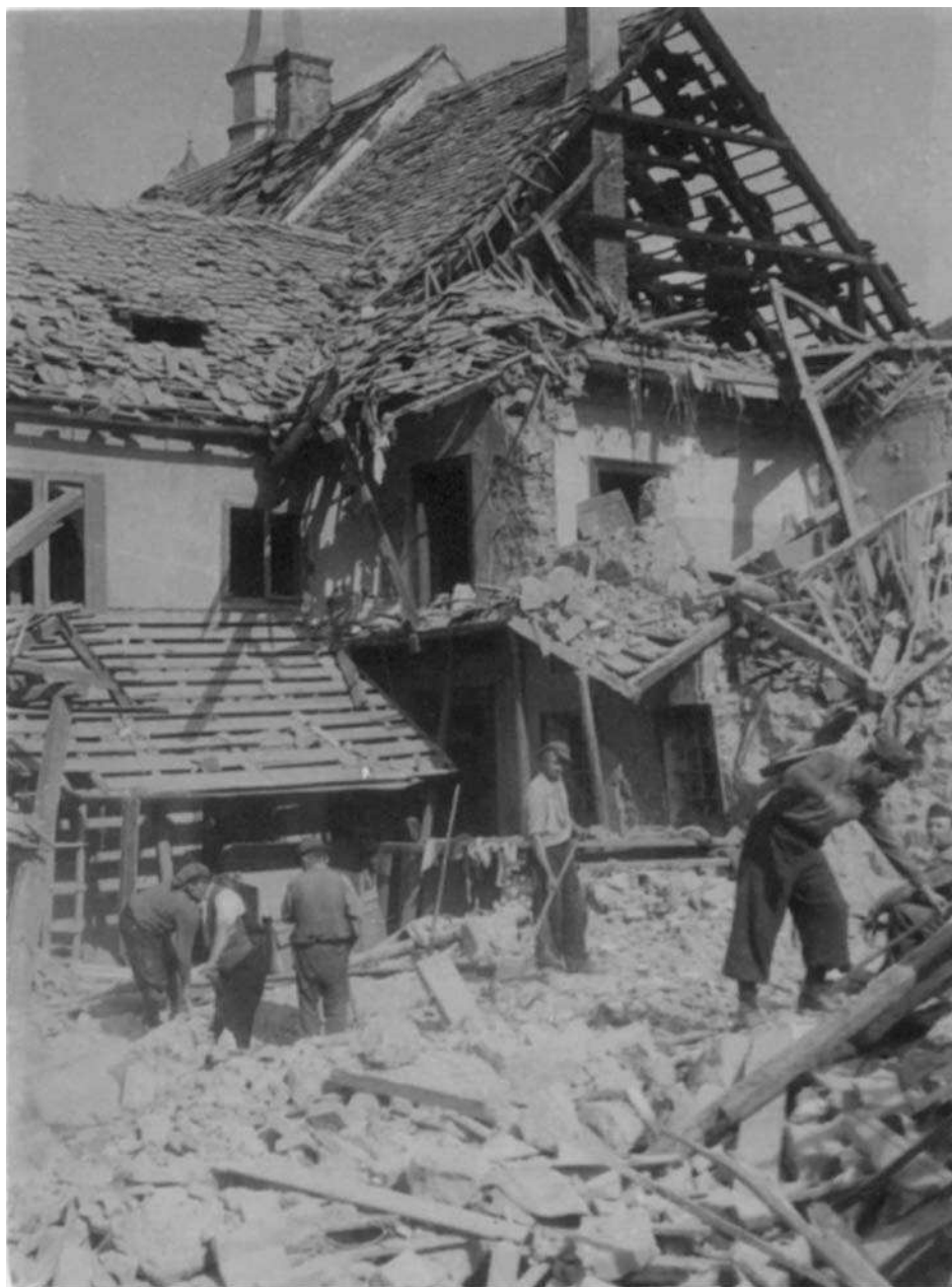
4. oktober 1943. Odkopavanje in odstranjevanje ruševin hiše Draga Satoška (št. 12). (Foto: Ivan Pirnat, original hrani Belokranjski muzej Metlika)
