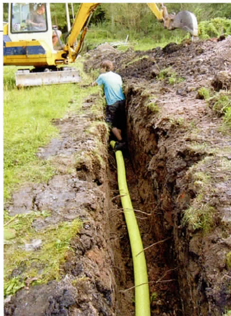
Izvajanje drenaže na območju v globino spuščajočega se rova rudnika, okoli 30 metrov od zakritega rudniškega jaska.
