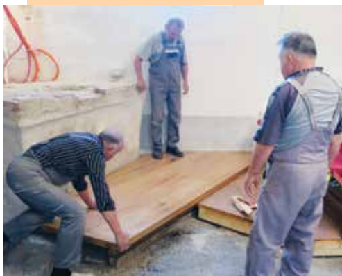
Montaža podestov pri stranskih oltarjih
