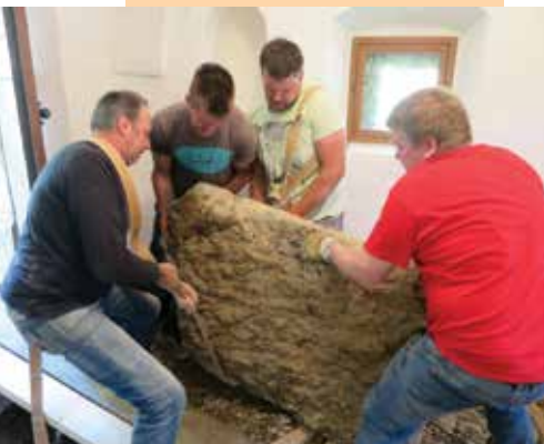
Demontaža originalnega kamnitega tlaka
