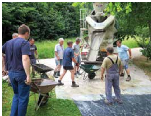
Betoniranje estriha
