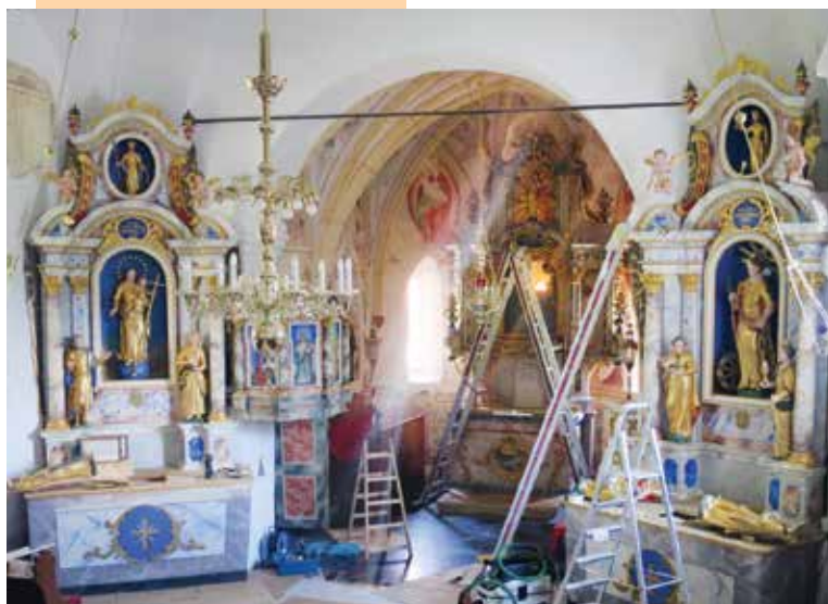
Montaža stranskih oltarjev
