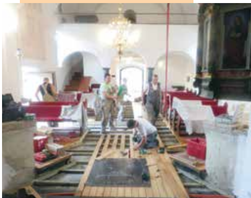
Montaža hrastovega poda
