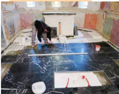
Montaža novega tlaka
