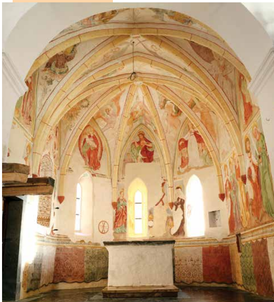
Stenske poslikave v prezbitteriju po konservatorsko- restavratorskih posegih, december 2018 (foto: Vid Klančar)
