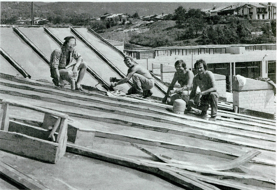
Gradbinci med delom na strehi nove cerkve Foto: Metod Zavadlav
