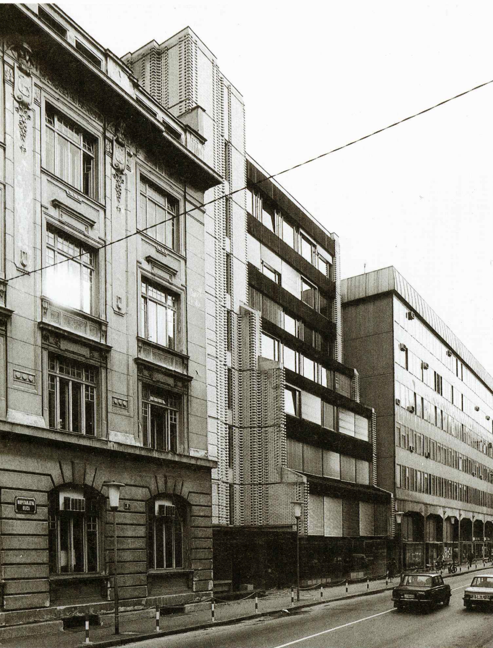
Stavba ČZP Ljudska pravica, Ljubljana, 1958-61 The building of the ČZP Ljudska pravica, Ljubljana, 1958-61
