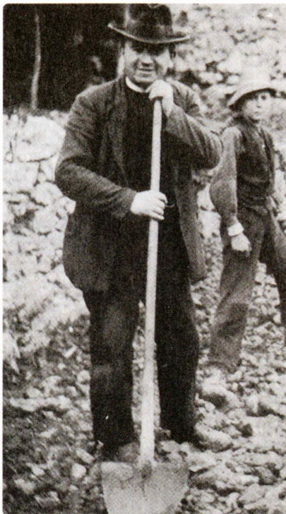
Kufol na prisilnem delu leta 1929. Italijanske oblasti so ga poslale na gradbišče ceste.
